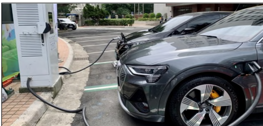
解說圖 847-1：直流充電設備
